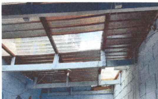
Foto 3: sustitución de lamina por lamina aluzinc en cocina
