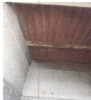
Foto 2: sustitución de estructura de soporte de madera por metal en Sanitarios
