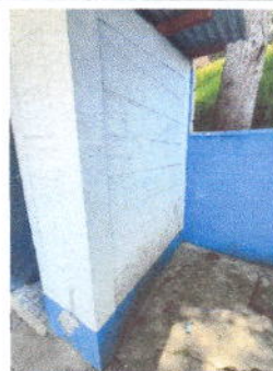
Foto 12: repello en muros
