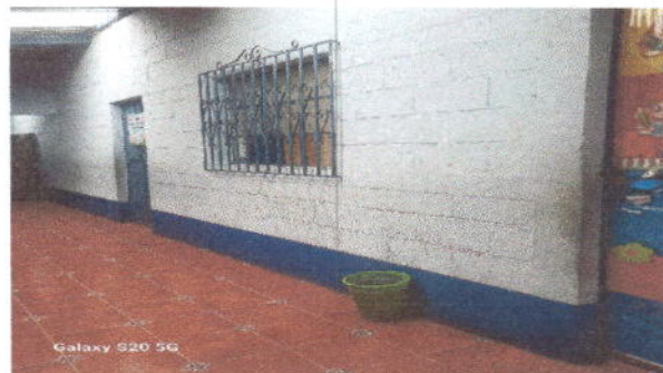
Foto 22: Pintura en muros exteriores e interiores
