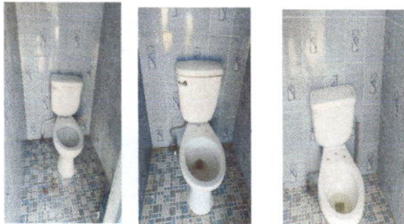
Foto7: sustitucion de inodoro
