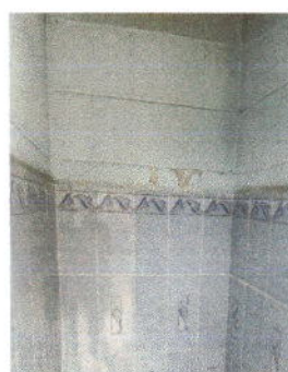
Foto 10: sustitución de azulejo
