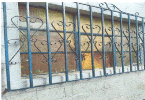
Foto 19: sustitucion de estructura de metal de ventana
