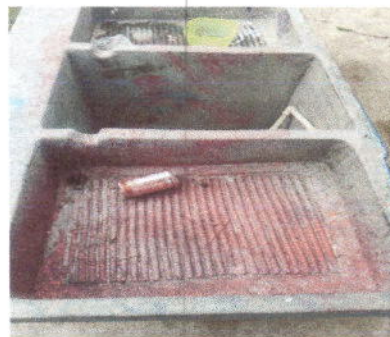
Foto 8: sustitución de lavamanos
