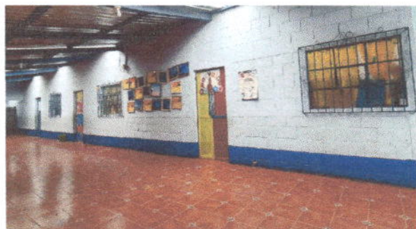
Foto 21: Pintura en muros exteriores e interiores
