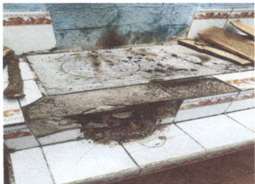
Foto 13: sustitución de plancha de metal de 3 hornillas
