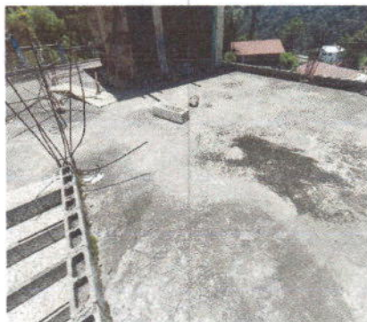
Foto 14: reparacion de pañuelos e impermeabilización de losa
