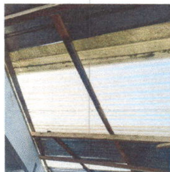
Foto 4: sustitución de estructura de soporte de madera por metal y lamina troquelada
