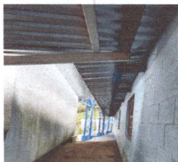
Foto 18: sustitución de canal
