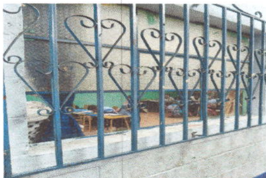
Foto 20: sustitucion de estructura de metal de ventana
