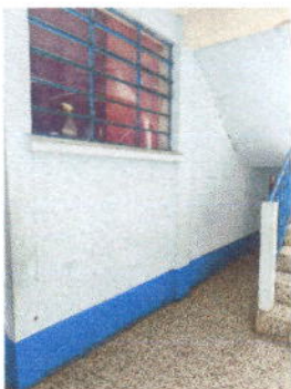
Foto 15: impermeabilización de paredes
