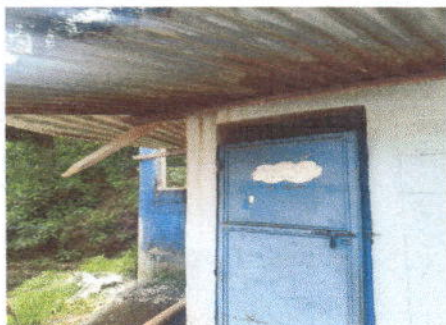
Foto 1: sustitución de lamina por lamina aluzinc en sanitarios
